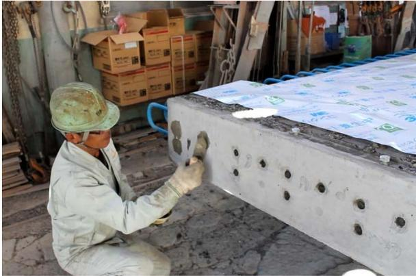
写真-21 仕上げ材による後埋め
