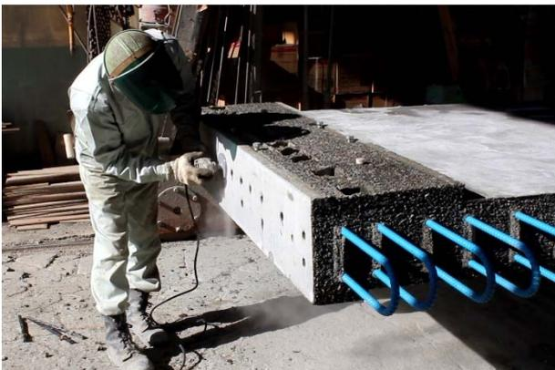
写真-12 床版側面の不陸調整状況
