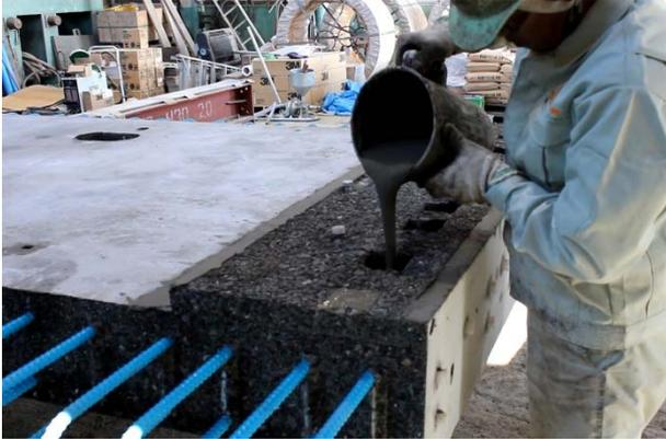
写真-15 無収縮モルタルの充填状況
