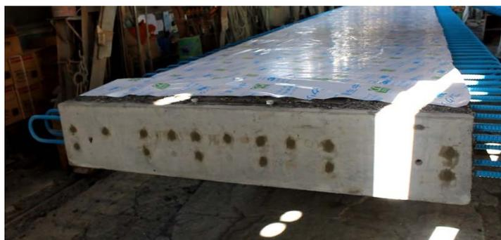
写真-1 充填材の後打ち完了(床版側面)
