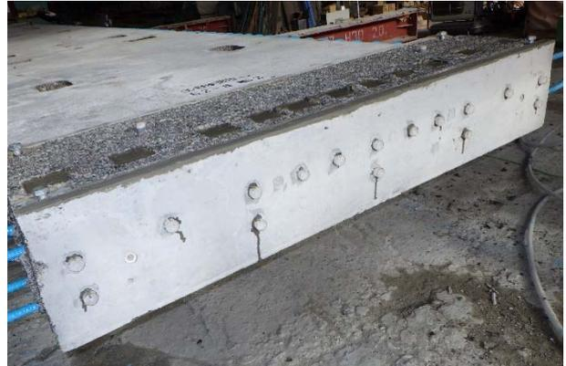
写真-16 無収縮モルタルの充填完了
