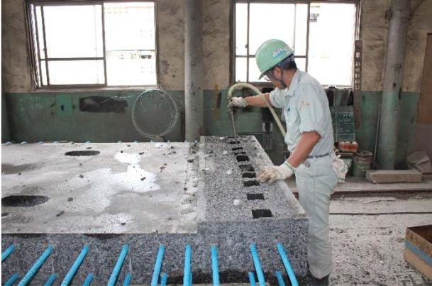
写真-10 切断孔内の清掃状況
