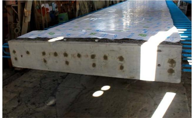
写真-22 仕上げ材による後埋め完了
