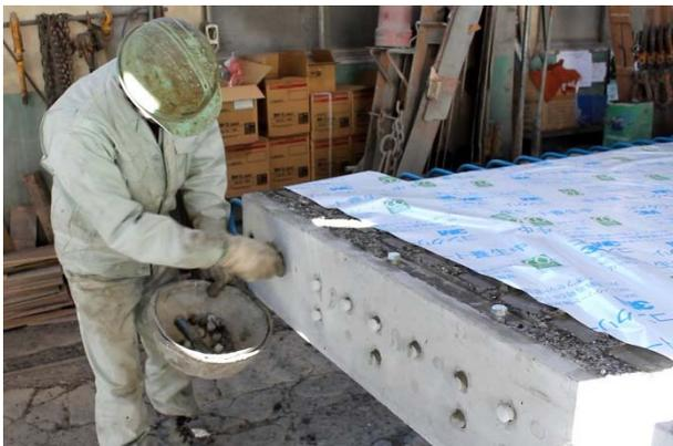
写真-19 プラスチック栓の撤去状況
