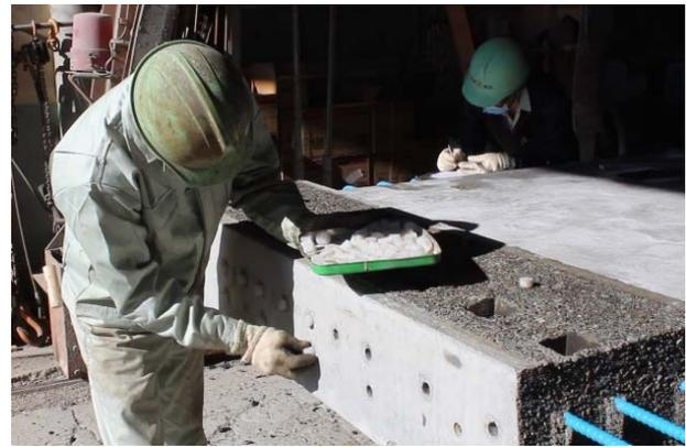
写真-13 プラスチック栓の設置状況
