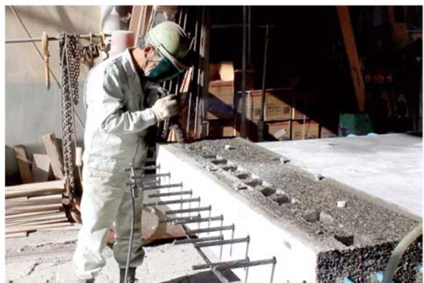
写真-9 PCケーブルの切断・撤去
