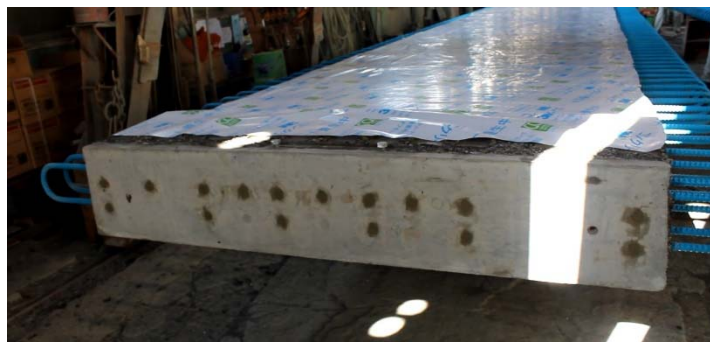
写真-1 充填材の後打ち完了(床版側面)
