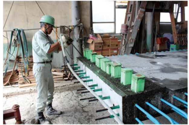
写真-7 切断孔の箱抜き材の撤
