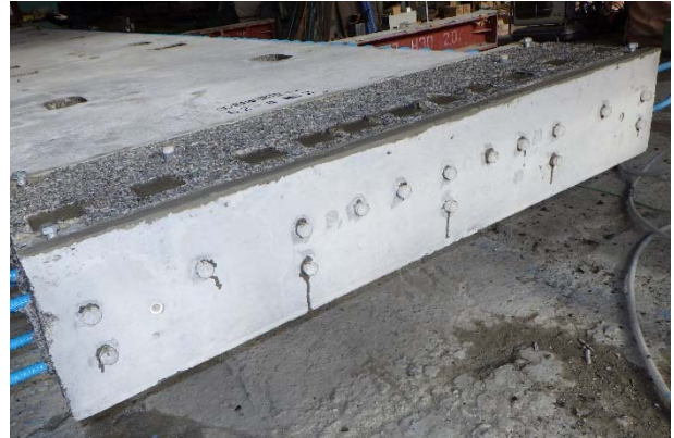
写真-16 無収縮モルタルの充填完了
