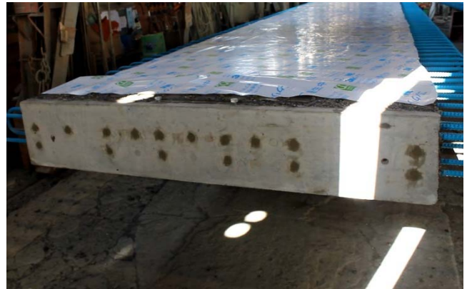
写真-22 仕上げ材による後埋め完了
