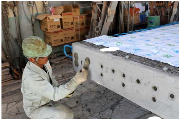
写真-21 仕上げ材による後埋め
