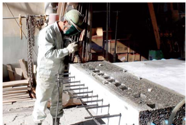
写真-9 PCケーブルの切断・撤去
