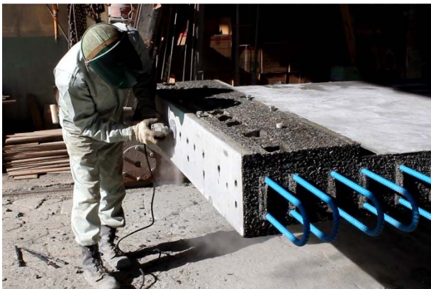
写真-12 床版側面の不陸調整状況
