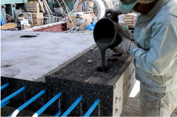
写真-15 無収縮モルタルの充填状況
