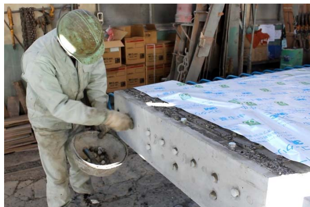
写真-19 プラスチック栓の撤去状況
