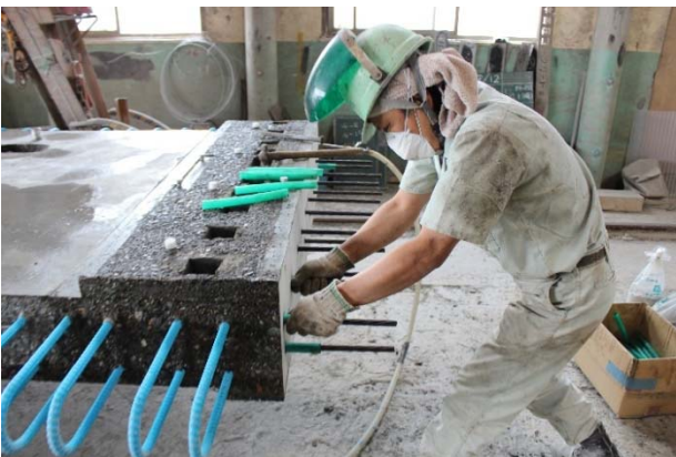
写真-8 ボンドレスホースの撤去
