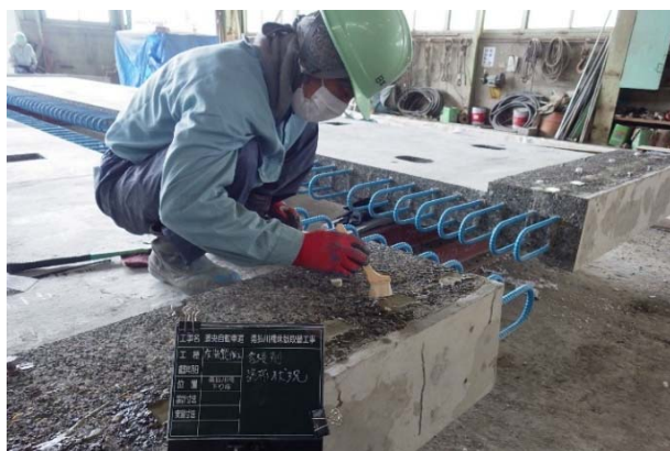
写真-23 表面含浸材の塗布
