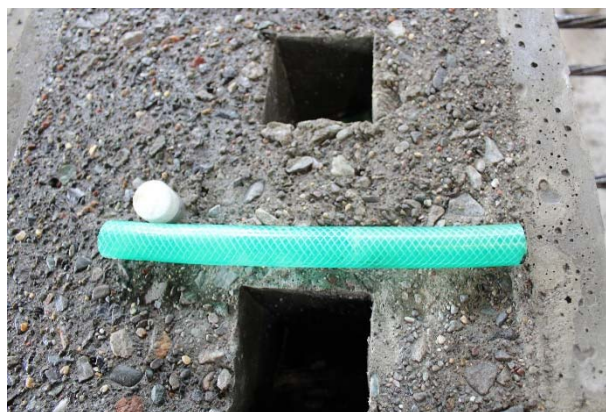
写真-5 ボンドレスホースの拡大写真
