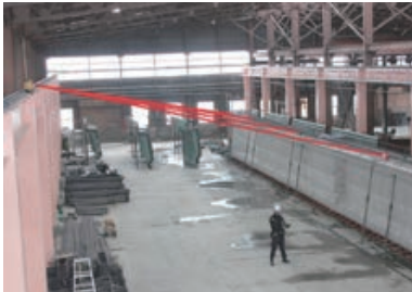
製作工場などにおける 主桁形状の計測
