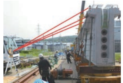
架設位置における接合精度確認
