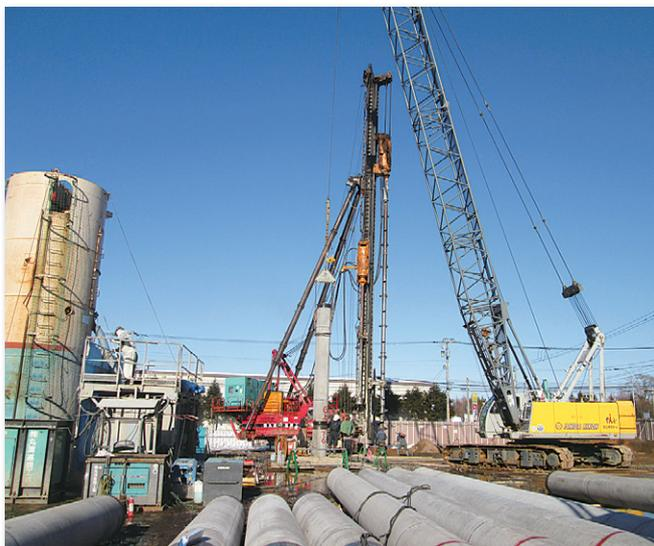
全長ストレート掘削で、特殊な専用下杭を必要としないシンプルな高支持力杭工法です。高支持力かつ多様な地盤に対応が可能で、高い経済性を発揮します。
