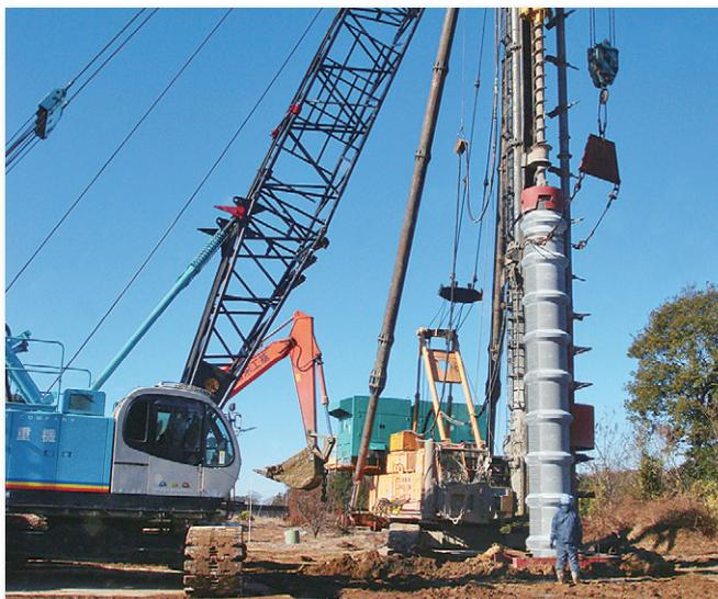
膨張性混和材による優れた摩擦力とシンプルな施工に加えて、豊富な組み合わせバリエーションを兼ね備えた工法です。
