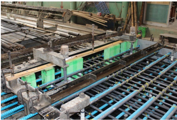
写真-2 切断孔の箱抜き材の設置
