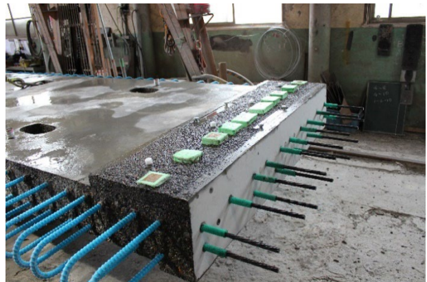
写真-3 ボンドレス用ホースの設置
