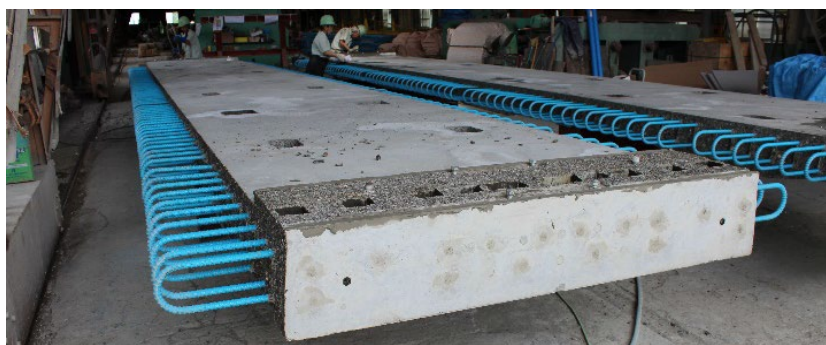
写真-1 充填材の後打ち完了(床版側面)
