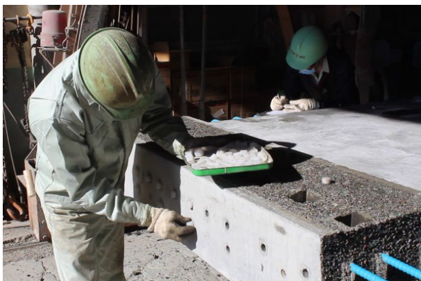
写真-8 プラスチック栓設置状況
