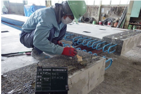
写真-10 表面含浸材塗布状況
