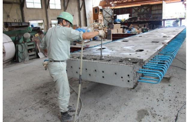
写真-7 切断孔内の清掃
