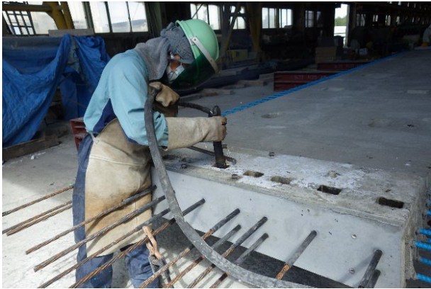
写真-6 PC鋼材の切断・撤去
