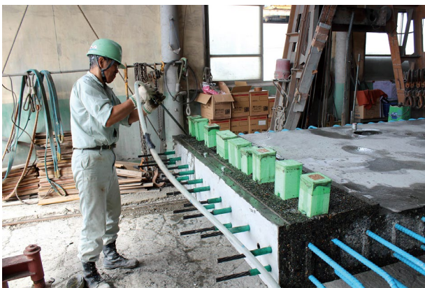
写真-4 切断孔の箱抜き材の撤去
