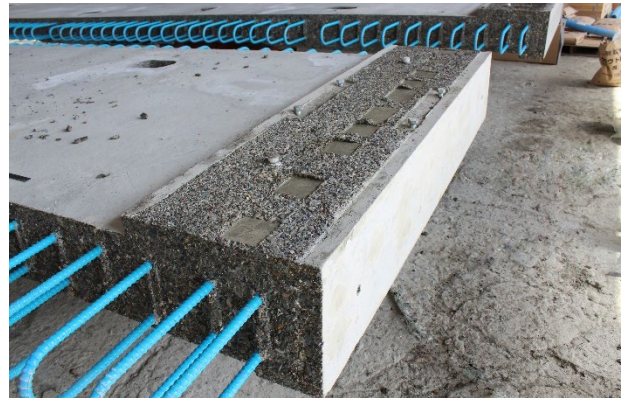
写真-11 充填材の後打ち部の仕上げ完了
