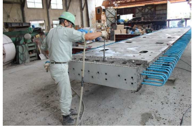
写真-7 切断孔内の清掃
