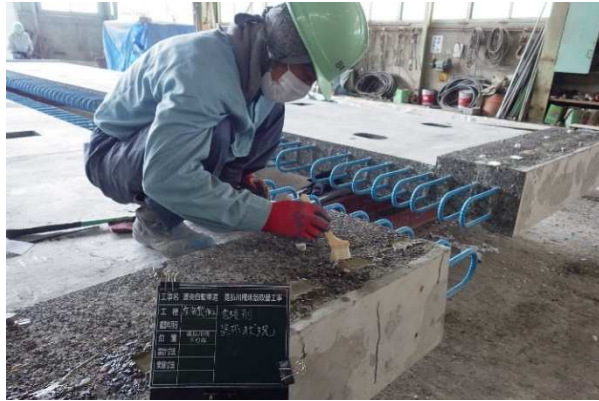
写真-10 表面含浸材塗布状況
