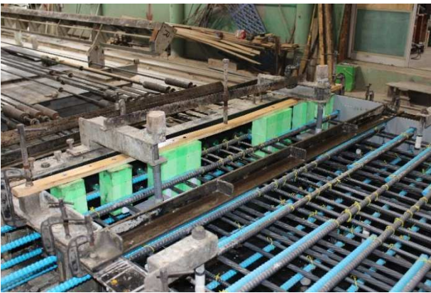
写真-2 切断孔の箱抜き材の設置
