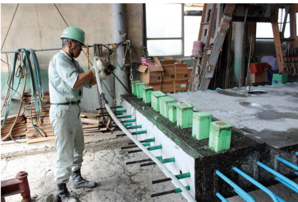
写真-4 切断孔の箱抜き材の撤去
