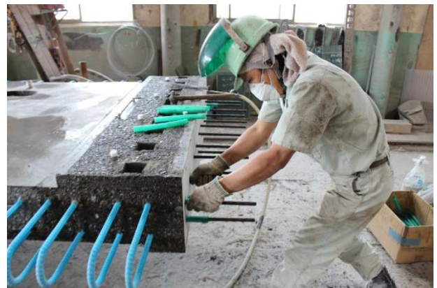
写真-5 ボンドレス用ホースの撤去
