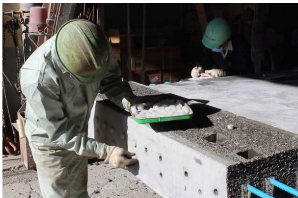
写真-8 プラスチック栓設置状況
