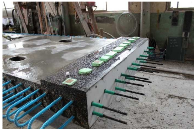
写真-3 ボンドレス用ホースの設置
