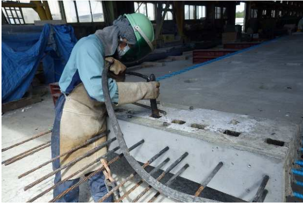
写真-6 PC鋼材の切断・撤去
