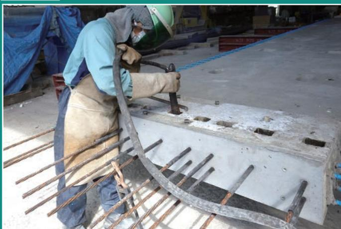
STEP 4 充填材の後打ち完了
