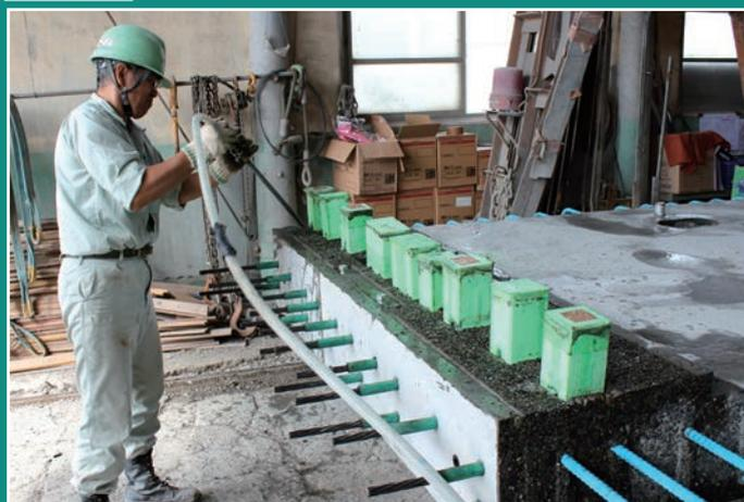
STEP 3 PCケーブルの切断・撤去
