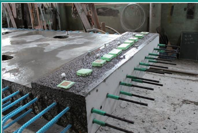
STEP 2 切断孔箱抜き材の撤去
