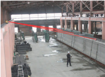
製作工場などにおける主桁形状の計測
