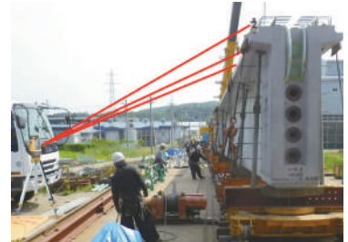
架設位置における接合精度確認
